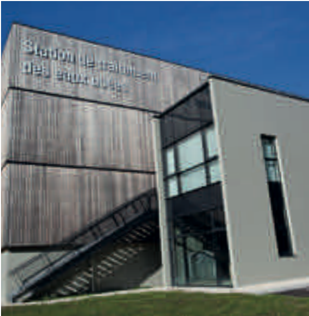
Above: Villard de Lans WWTTP © vercors.org
